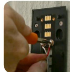
Falls Sie eine bestehende Türklingel ersetzen, muss die Verdrahtung mit einem Trafo mit einer Spannung von **8 VAC - 24 VAC** verbunden sein.
